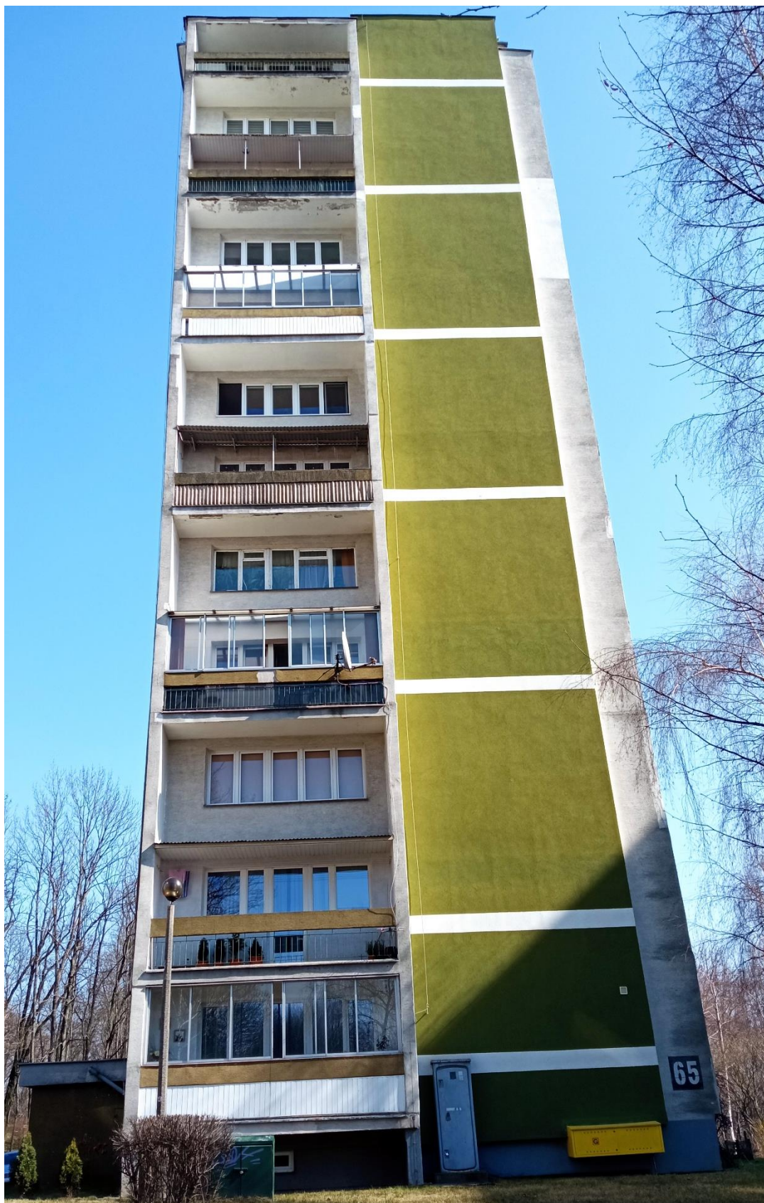
Fot. 1. Widok ogólny na elewację zachodnią
